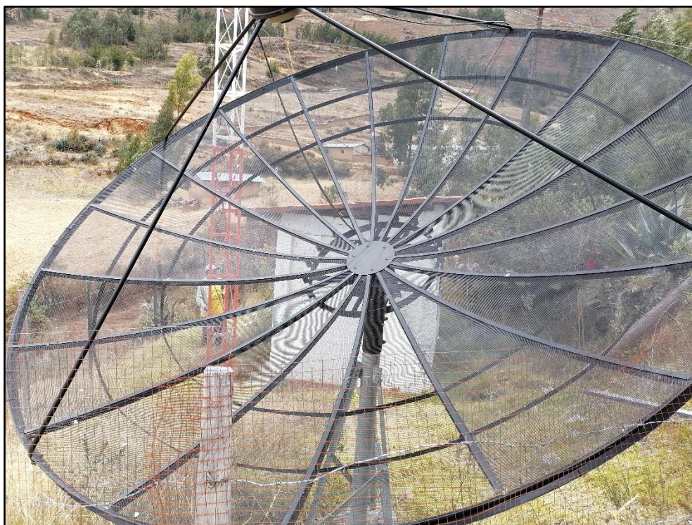
Imagen 1. Antena Parabólica cuenta con 2 pétalos averiados.
